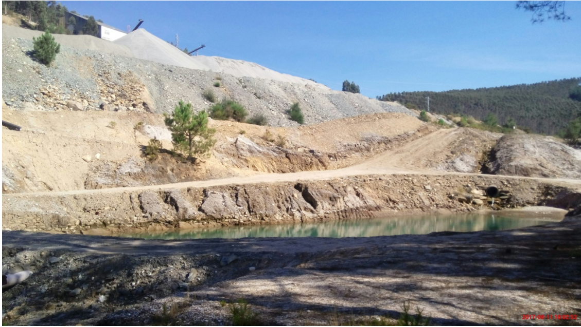
Figura 13. Evidencias de inestabilidade da balsa de decantación final. Fotografía tomada en agosto de 2017.
