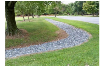
Trincheiras de infiltração
