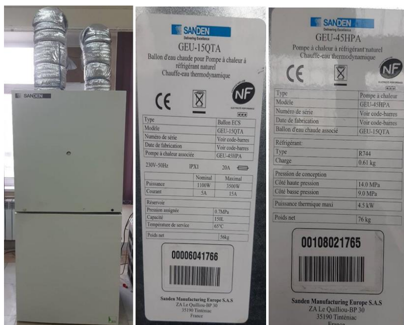
Рисунок 13. Тепловой насос «воздух-вода», работающий на экологически чистом хладагенте CO 2 (R744)
