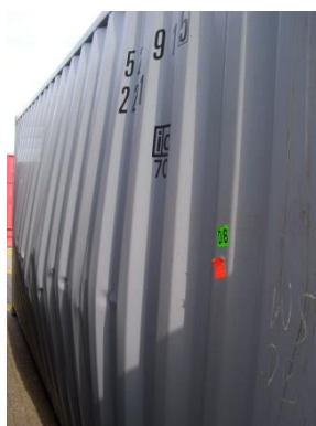
Figure 7.70 Renvlement de la paroi
