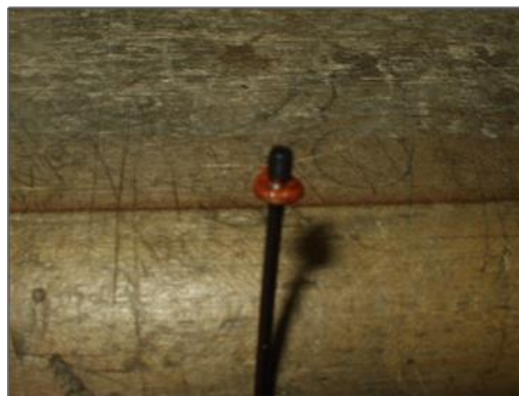
Рис. 34 Обработка винтовой заглушки герметиком
