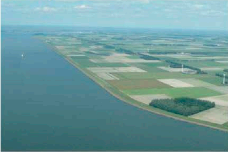
Westermeerdijk met bestaande opstelling
