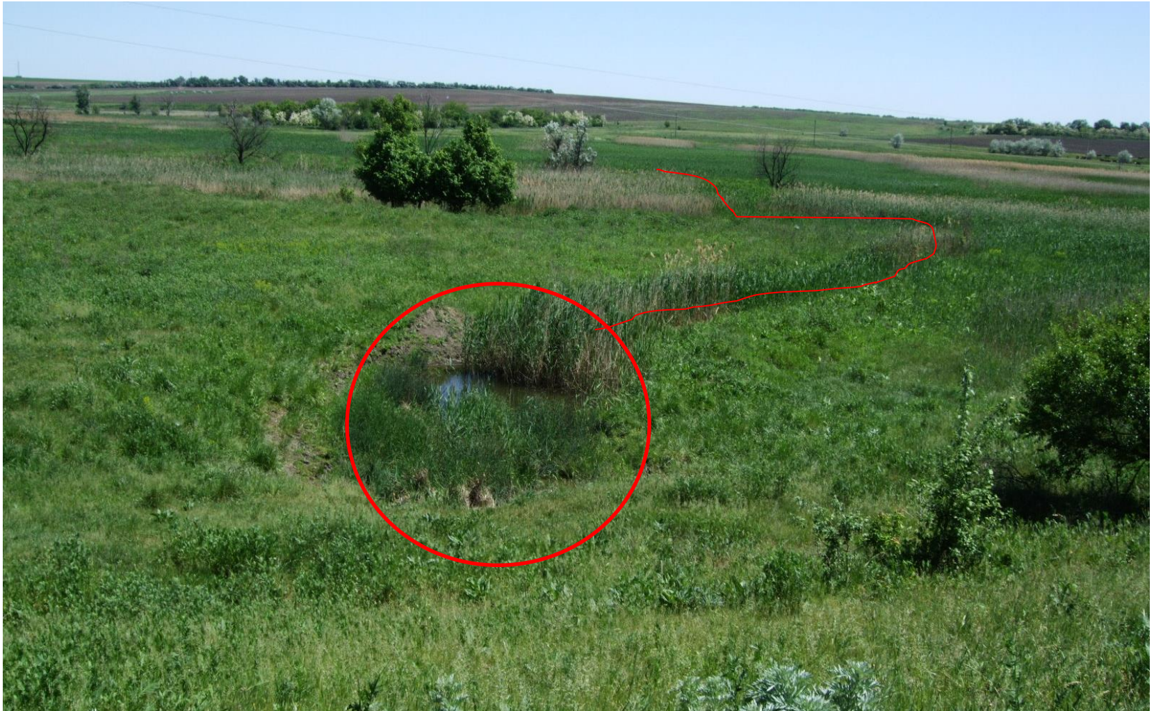
Фильтрация воды через дамбу и выход в виде родника. (Вид с дамбы)
