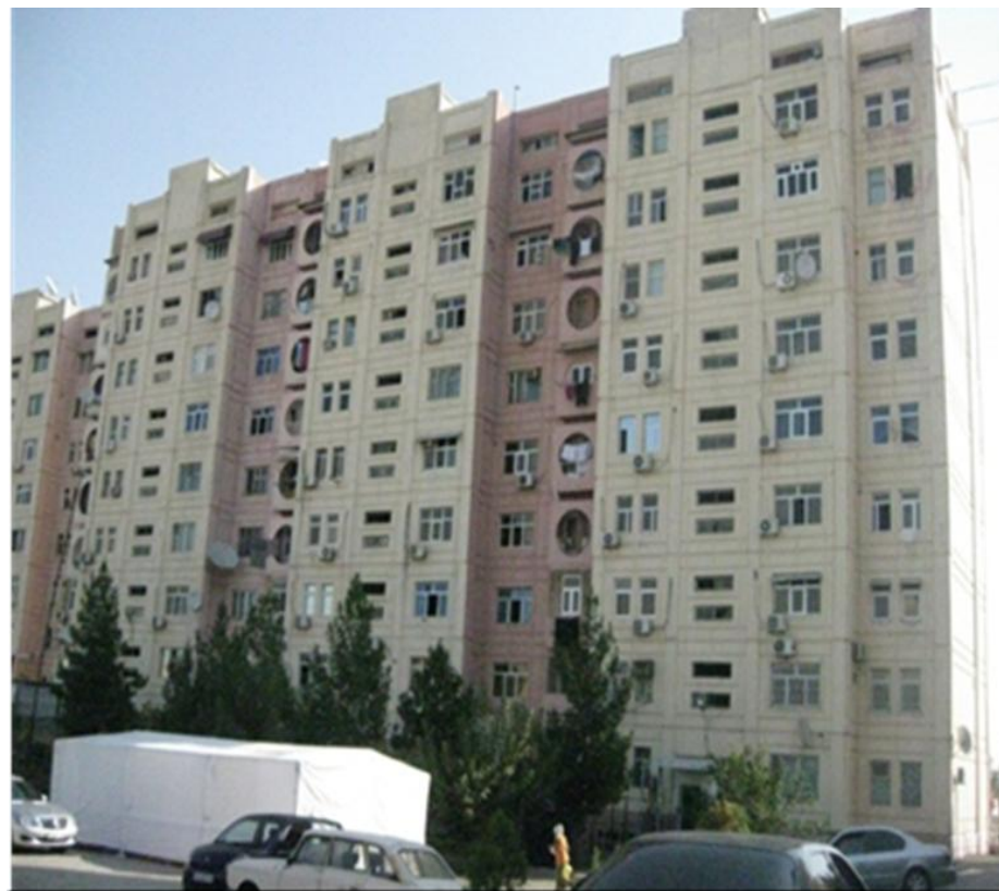
Рис.№2. Вид переднего фасада №15 здания.
