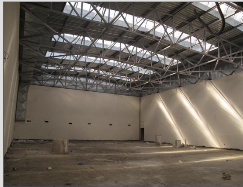
Естественное освещение спортивного зала
