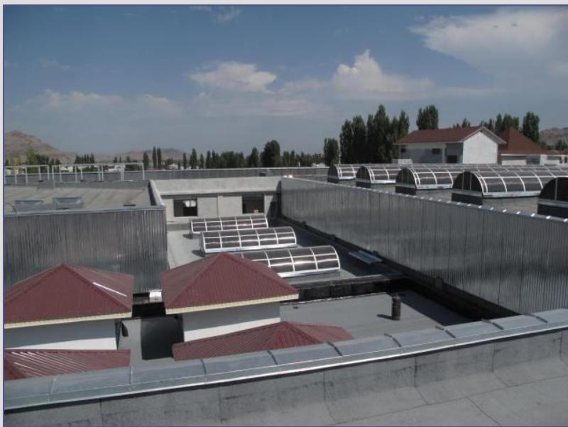
Светопрозрачные фонари на кровле
