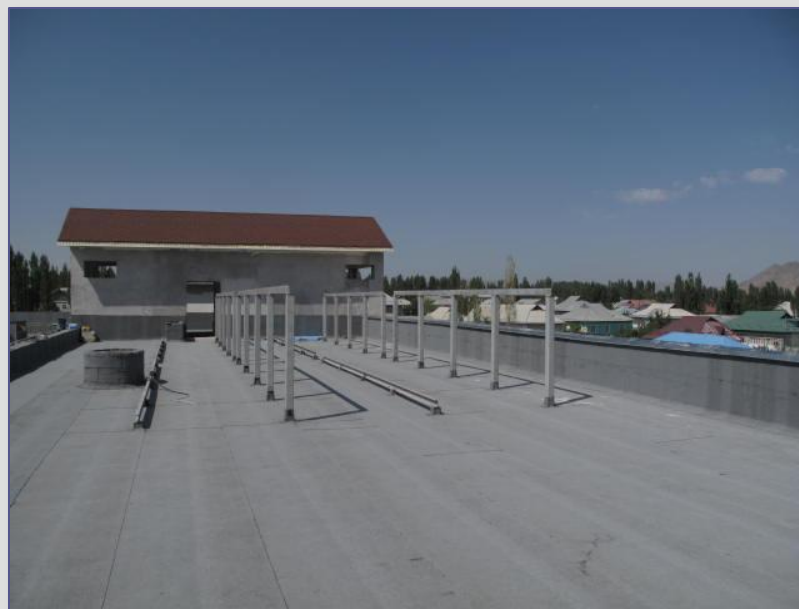
Монтаж солнечных установок для нагрева ВОДЫ
