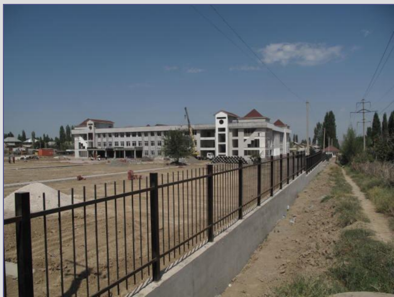
Общий вид строительства
