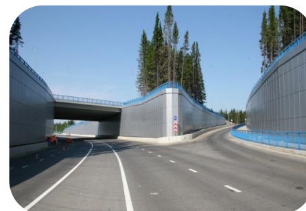
Объездная дорога Бишкек-Кара- Балта
