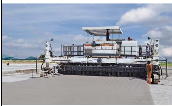
Бетоноукладчик со скользящими формами в действии
