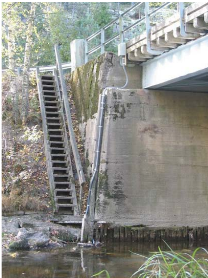
Рис. 5. Гидрологическая измерительная станция.
