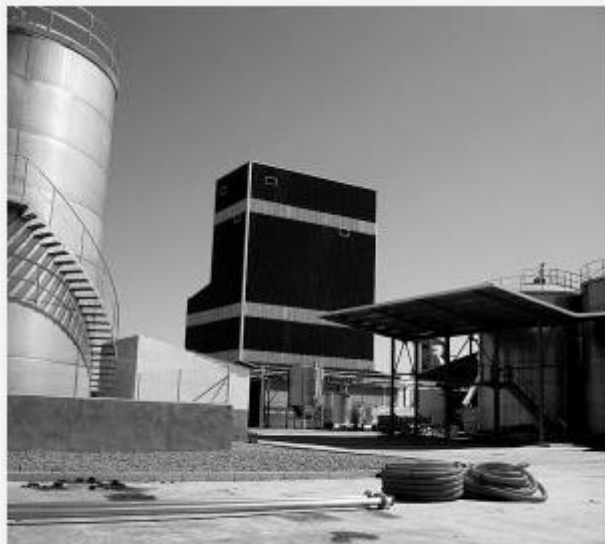
En esos días se ultima la construcción de la planta. / G. C.
