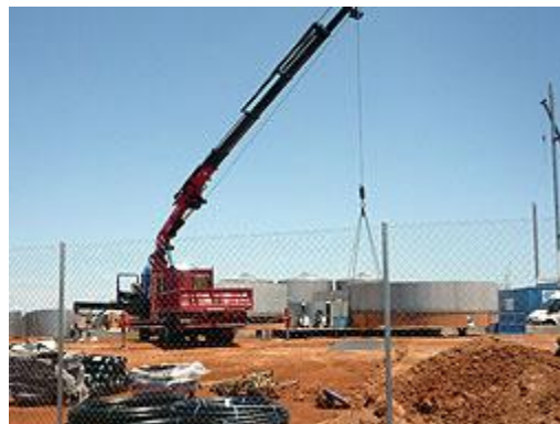
Obras de la nueva alcoholera en la carretera de Arroyo. / I. V.
