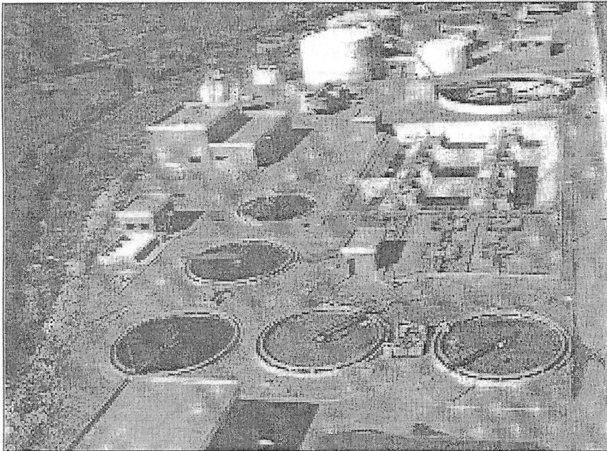
Depuradora de aguas residuales
