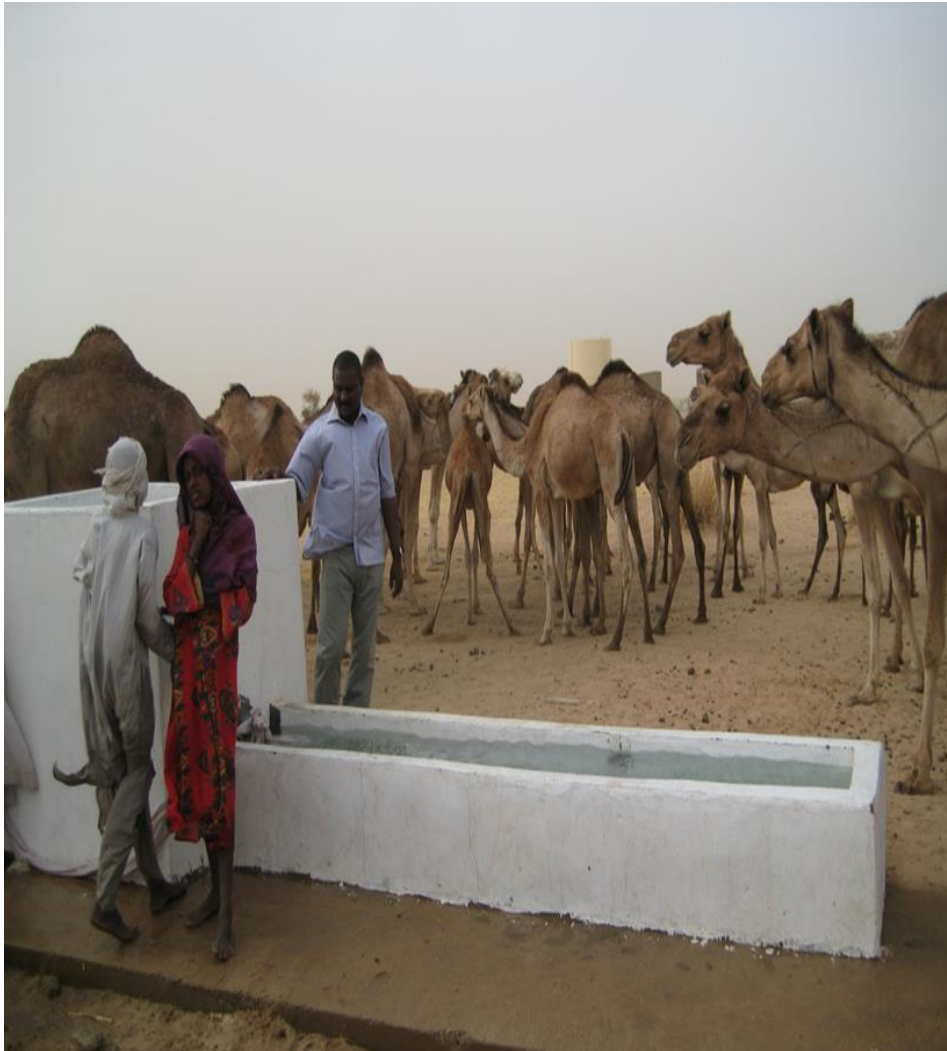
ABREUVOIR D'UNE STATION DE POMPAGE PASTORALE
