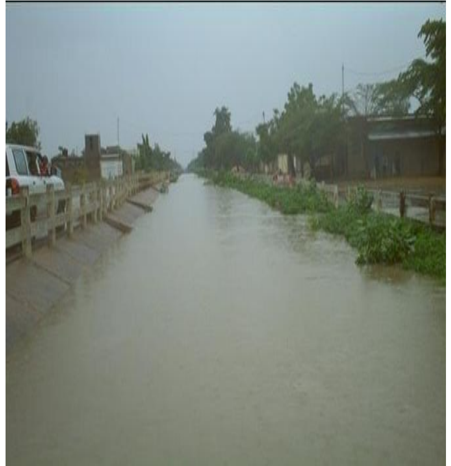
CANAL D'EVACUATION DES EAUX PLUVIALES
