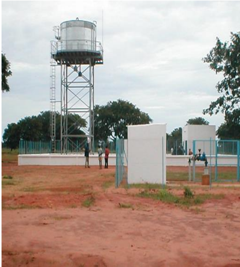
CHÂTEAU D'EAU MÉTALLIQUE
