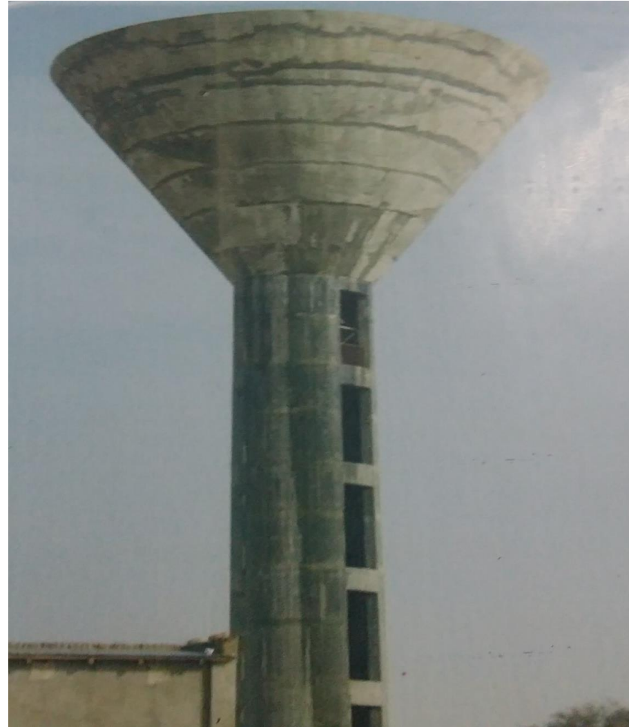
CHÂTEAU D'EAU EN BETON ARMÉE
